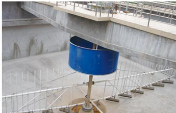
中心传动浓缩机 Center Drive Sludge Thickener
