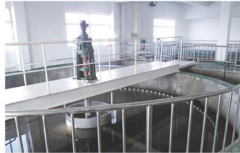
中心传动刮泥机 Center Drive Sludge Scraper
